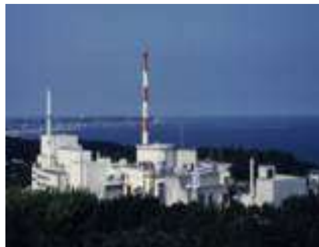
高速実験炉常陽
