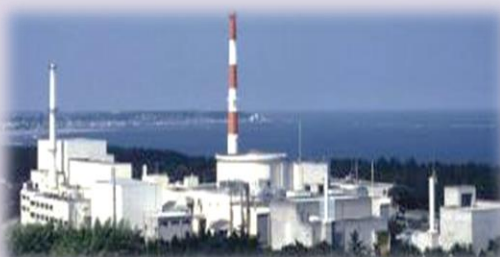
高速実験炉「常陽」
